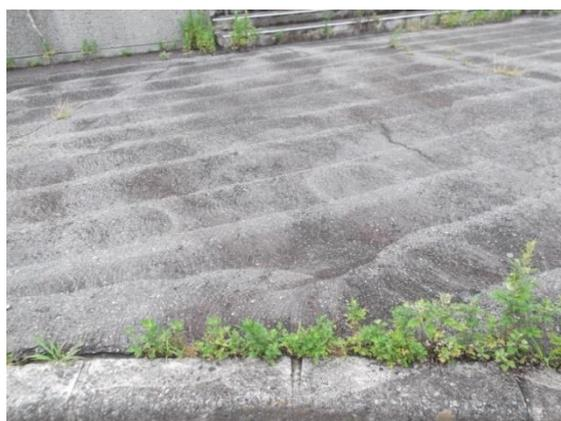
定されています。しかし、ほとんどが帰還困難地域です。A区域・B区域の避難指示は平成29年3月に解除される予定です。現在A区域・B区域は、日中の立入りは可能で、私たちはA区域にある浪江駅に行きました。右の写真は浪江駅前のコンクリートの歩道を削って除染した跡です。除染していますが、コンクリートの表面を測ると放射線量は未だ $2.5 \mu\text{Sv/h}$ と高い状況でした(通常 $0.05 \mu\text{Sv/h}$ 程度)。近くで下水道工事が行われていましたが、作業員はマスクをしていませんでした。
