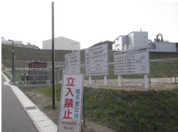
写真は飯舘村に設置されている環境省の再資源化センター（左中央）と除染可燃物の焼却場（右）です。再資源化センターでは、可燃除染廃棄物の灰はセメントの原料として、除染土砂は加熱することでセシウムなどを気化させて放射線レベルを下げ、護岸堤防の材料や道路の路盤材として再利用する計画を進めています。避難指定地区では国が、指定以外の地区においては自治体が、除染物を入れたフレコンバッグの仮置き場と減容化施設を設置しています。
