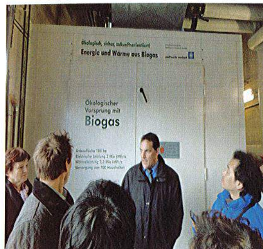
バイオガスコジェネ発電所
